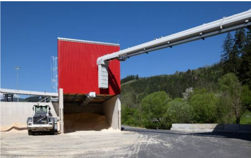
Photo 5 : la fine matière déchetée est ensuite transportée par le système de convoyage à bande tubulaire VRF 500 P jusqu'au crible oscillant VSS 6000 situé au-dessus des bacs à copeaux.
