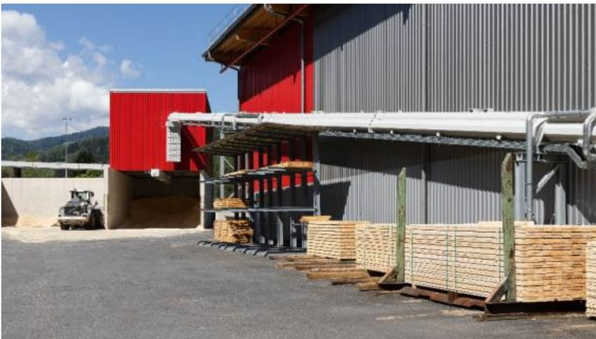
**Bild 3:** Das VRF 500 P wurde speziell für einen sauberen und geräuscharmen Transport von Schüttgütern über lange Distanzen entwickelt und wird bei Schaffer auf einer 80 Meter langen Strecke über den gesamten Werkhof eingesetzt.
