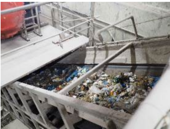
Bild 8: Die Förderanlage transportiert den zerkleinerten Output aus der Maschine.
