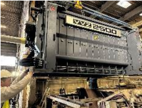
Bild 7: Die Anlage wurde demontiert und neu aufgebaut.
