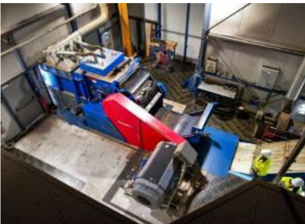
Bild 3: Die Beschickung des Materials erfolgt im Freien über ein Förderband – der eigentliche Zerkleinerungsvorgang aus Lärmschutzgründen in der Halle.
