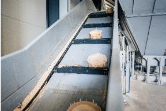
Bild 2: Die Förderanlage transportiert die Kappscheiben zum VHZ 1600 zur Vorzerkleinerung.
