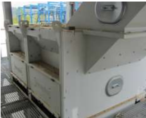
Bild 5: Das Scheibensieb befreit die Biomasse von zu langen Hölzern. Die aussortierten Überlängen gelangen direkt zu einem Container.
