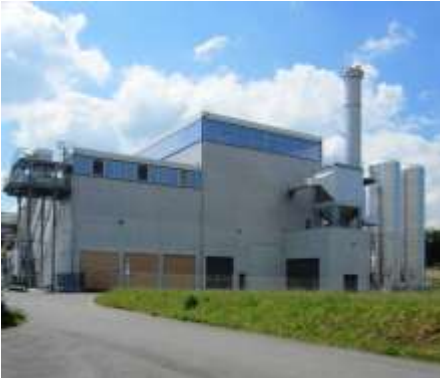
Bild 1: Das Biomasse-Heizkraftwerk in Pratteln: nachhaltig, erneuerbar und emissionsfrei.
