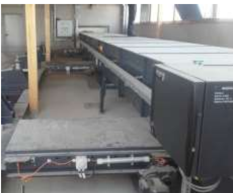
Bild 6: Über einen Kettenförderer gelangt das Material zum Lager.
