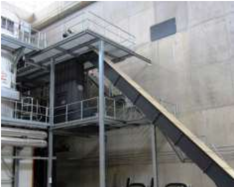
Bild 7: Ein Kratzkettenförderer transportiert die Biomasse zum Kessel.
